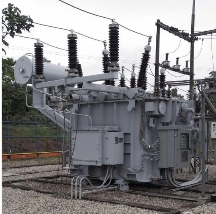
*Fotografía 2. Transformador de Potencia GAMMA2*
