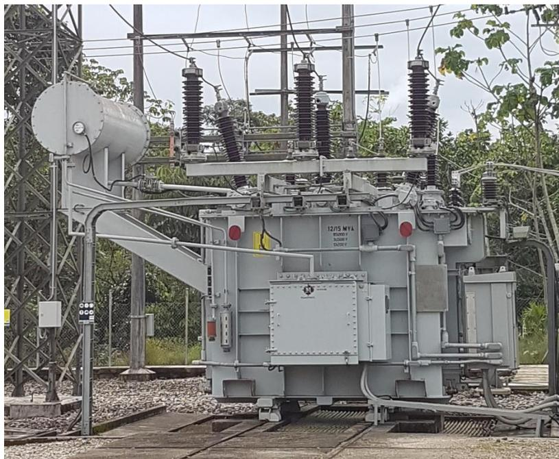
*Fotografía 3. Transformador de Potencia GAMMA3.*
